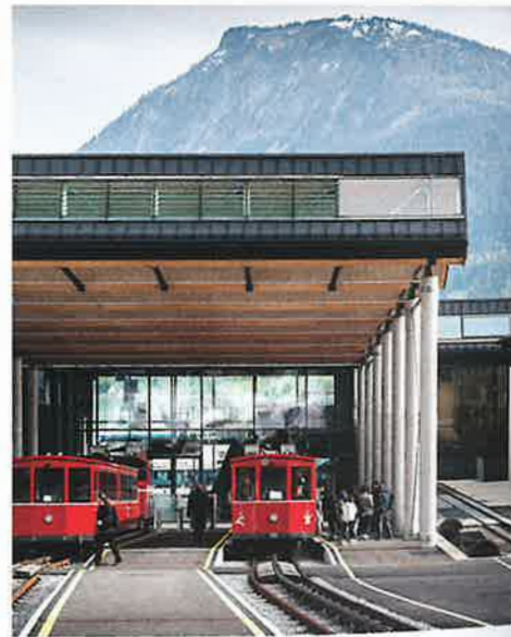
Ein innovatives Brandschutzkonzept ermöglichte auch im Bereich der Bahnsteigüberdachung den Einsatz von Holz.
