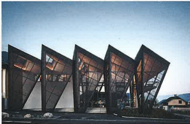
Die Faltung des Daches klappt als zweite Fassaden-ebene in die Vertikale und setzt das gestalterische Motiv des Falterwerks in den Ansichten fort.
