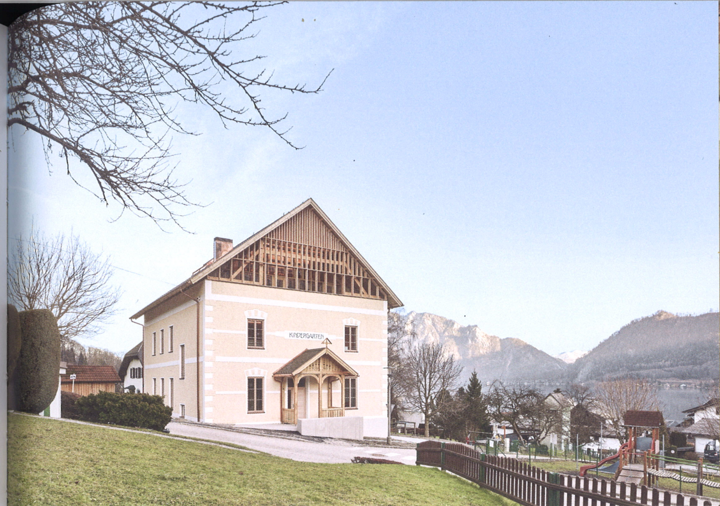
Nach dem Umbau
